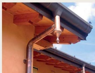
Esempio di grondaia in rame
