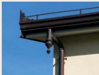
Esempio di grondaia in lamiera zincata
