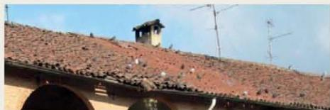
Degrado del manto di copertura e cedimento della struttura portante del tetto
