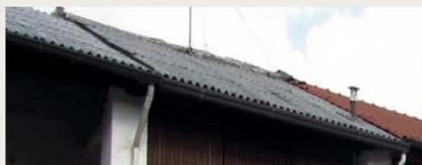
Sostituzione del manto di copertura originale con copertura in fibrocemento
